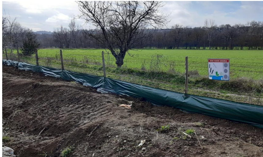
Figure 18 : Dispositif anti-intrusion posé sur clôture définitive ou provisoire (Source : SOLER IDE)
