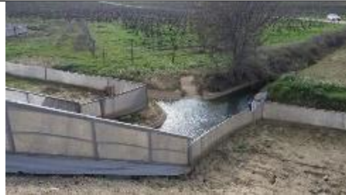
Figure 17 : Clôture anti-intrusion autour d'un cours d'eau (Source : SOLER IDE)
