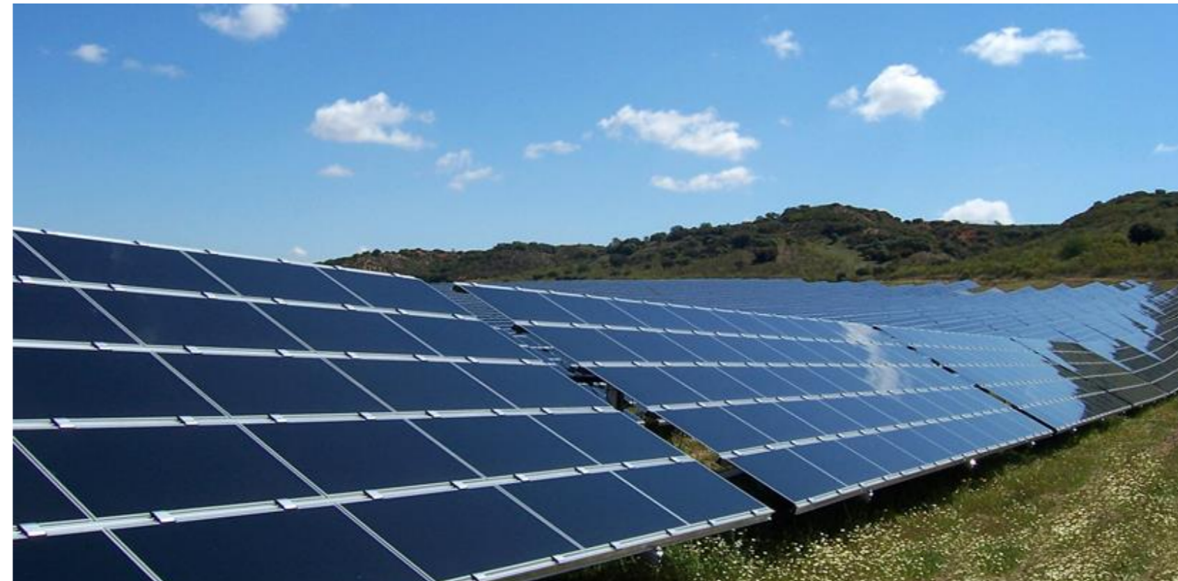
Parc photovoltaïque EDF Renouvelables de Narbonne
