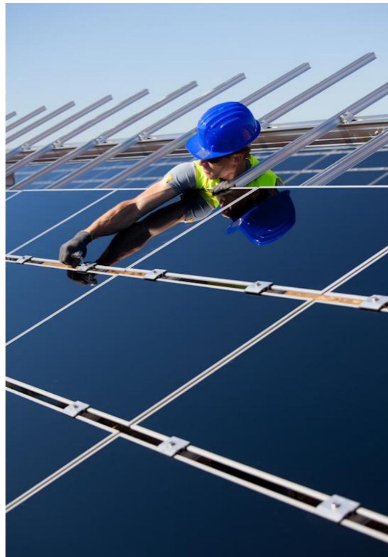
Remplacement de module (crédit photo EDF Renouvelables)
